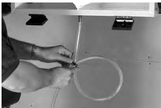
Former un siphon dans le conduit.
