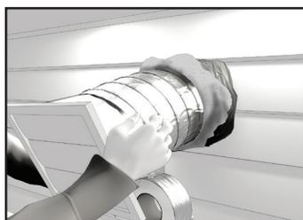
**2** Faites passer le conduit flexible isolé dans l'ouverture jusqu'à ce qu'il soit bien tendu et droit. Faites glisser le manchon en vinyle interne du conduit sur le collet avec l'isolation et placez le parevapeur sur le manchon. Fixez à l'aide de ruban adhésif en toile.
