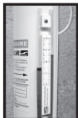
EL VENTILADOR FUNCIONA
